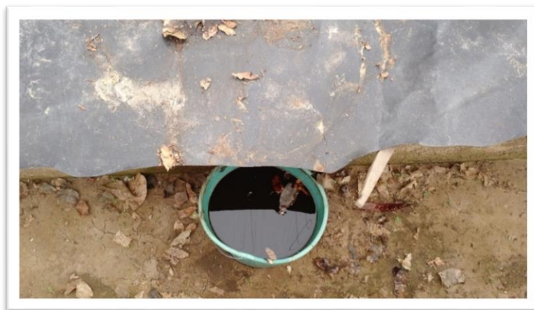
Figura 10. Captação do lixiviado.
