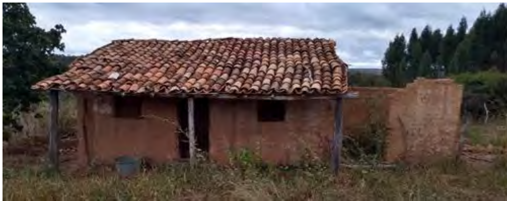
IMAGEM 5: ANTIGA CASA DE ENCHIMENTO
