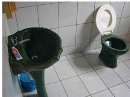
Foto 22 Banheiro de Ronaldo, Terra Livre - Resende [RJ], 2006. [doc.fot.] / Foto Thiago Ferreira.
