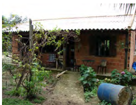
Foto 12 Casa nova de alvenaria, Terra Livre - Resende [RJ], 2006. [doc.fot.]. Foto Thiago Ferreira.
