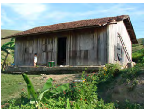
Foto 11 Casa de madeira, Terra Livre - Resende [RJ], 2006. [doc.fot.]. Foto Thiago Ferreira.
