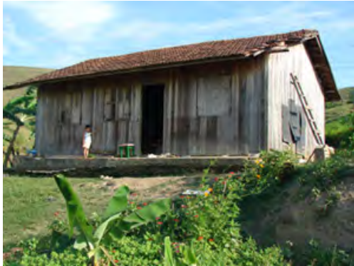
Foto 96 Vista geral da casa, Terra Livre - Resende [RJ], 2006, [doc.fot.] / Foto Thiago Ferreira.
