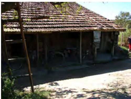
Foto 69 Vista da varanda da casa, Terra Livre - Resende 2006. [RJ], [doc.fot.] / Foto Thiago Ferreira.
