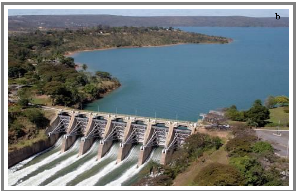
Figura 3. (a) Usina hidrelétrica de Três Marias. (b) Detalhe do vertedouro da usina hidrelétrica de Três Marias (Fonte: CEMIG, 2011).
