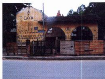
Ruína da Estação de Ferro de Vila da Cava
