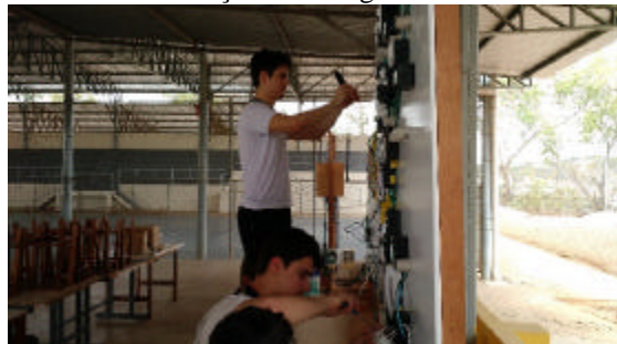
Instalação dos pontos de comandos e tomadas
