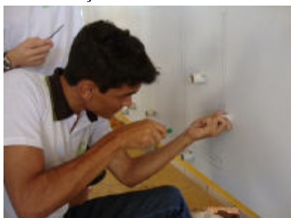
Instalação dos pontos de luz
