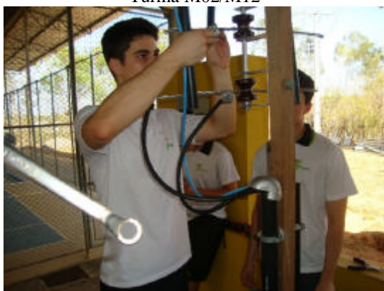
Instalação do Ramal de entrada
