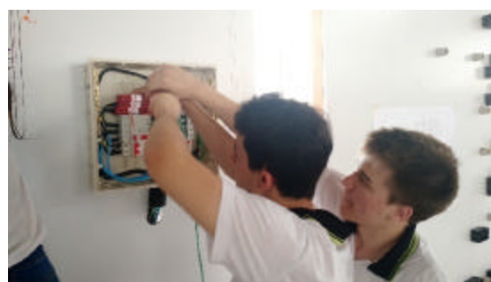
Instalação do quadro de distribuição e dispositivos de proteção
