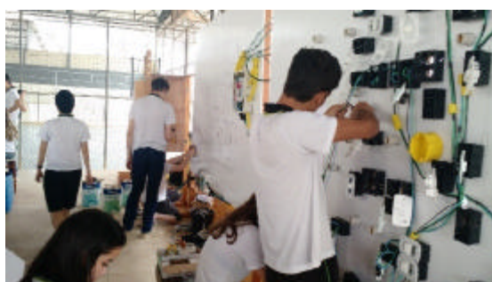
Instalação dos circuitos elétricos terminais
