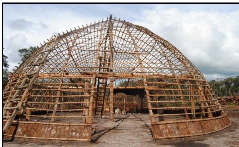
Figura 65. Parte frontal da estrutura de madeira da hátí .
