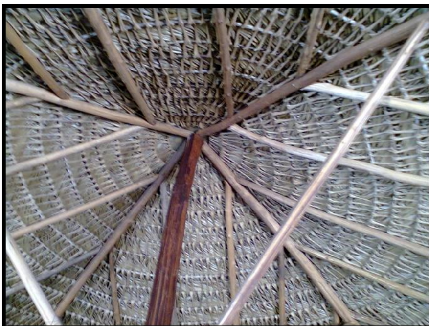
Figura 67. Parte interna de uma hátí , em formato de cone.
