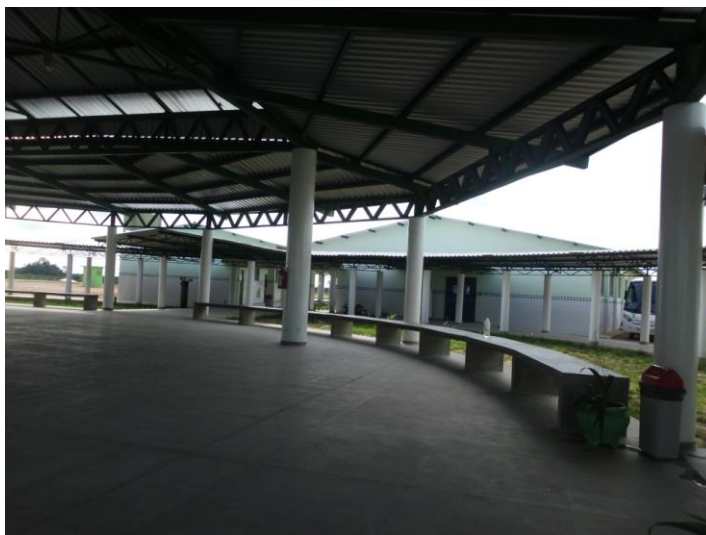
Figura 3 - Área de convivência e acesso às salas de aula e biblioteca do CAM
