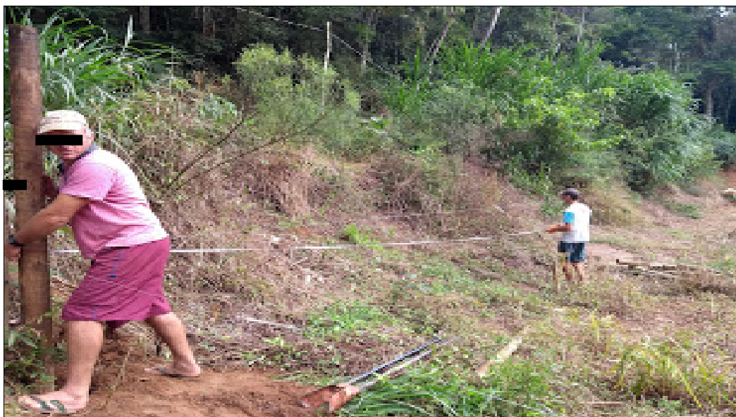
Figura 20: Estufa em fase inicial da construção
