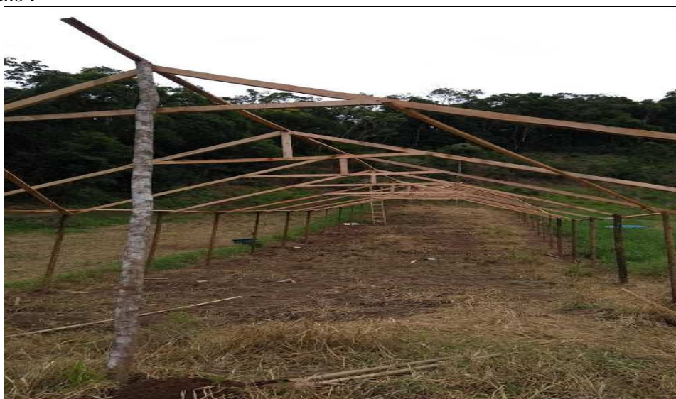
Figura 21: Estufa em fase intermediária de construção
