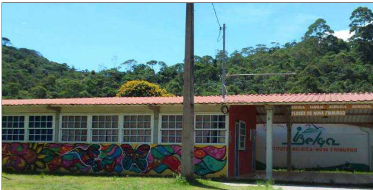
Figura 03: Fachada da Escola Municipal CEFFA Flores de Nova Friburgo
