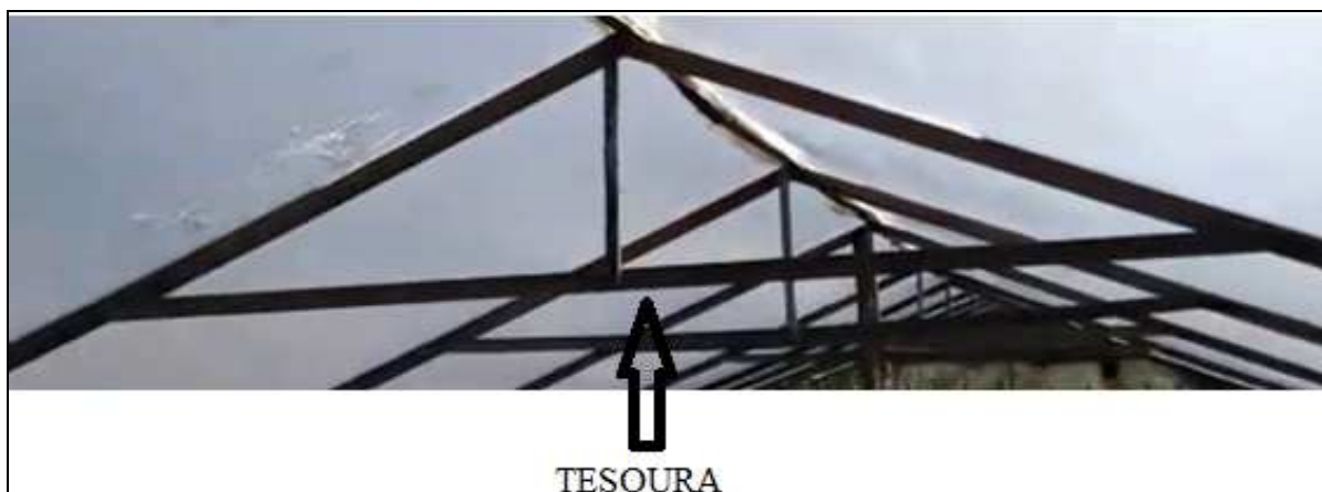
Figura 25: Parte superior de uma estufa com indicação da “tesoura”
