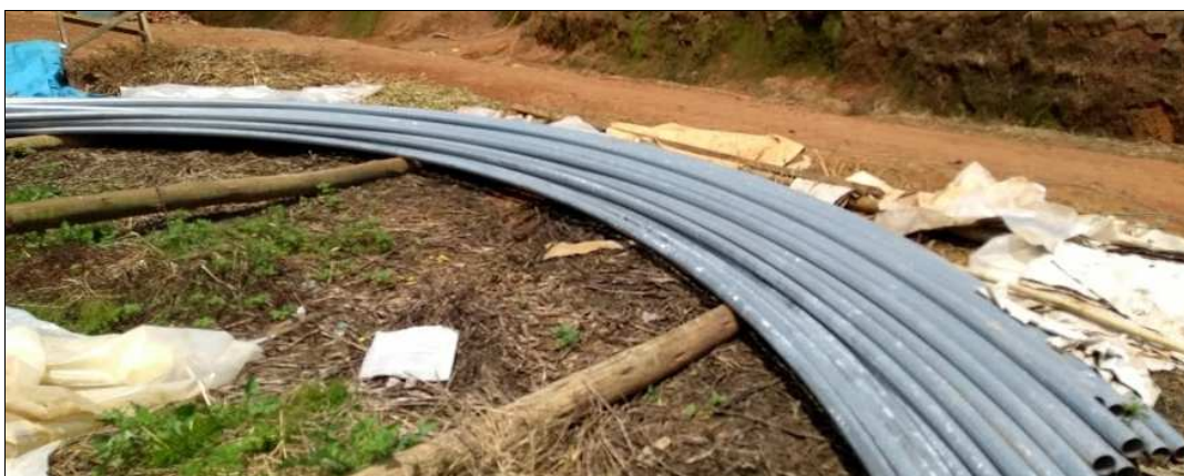
Figura 23: Arcos de alumínio que ficarão na parte superior de estufas
