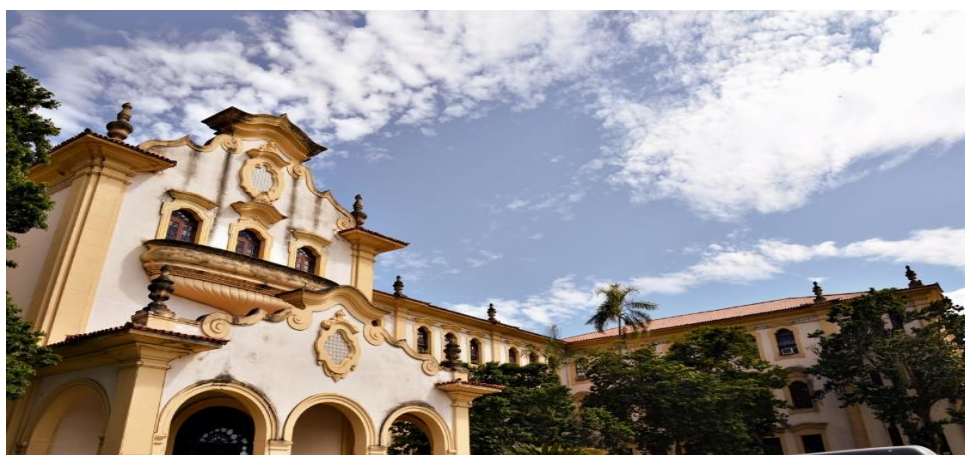
Figura 5: Pavilhão Central da Universidade Federal Rural do Rio de Janeiro. Fonte: UFRRJ (2018b)
