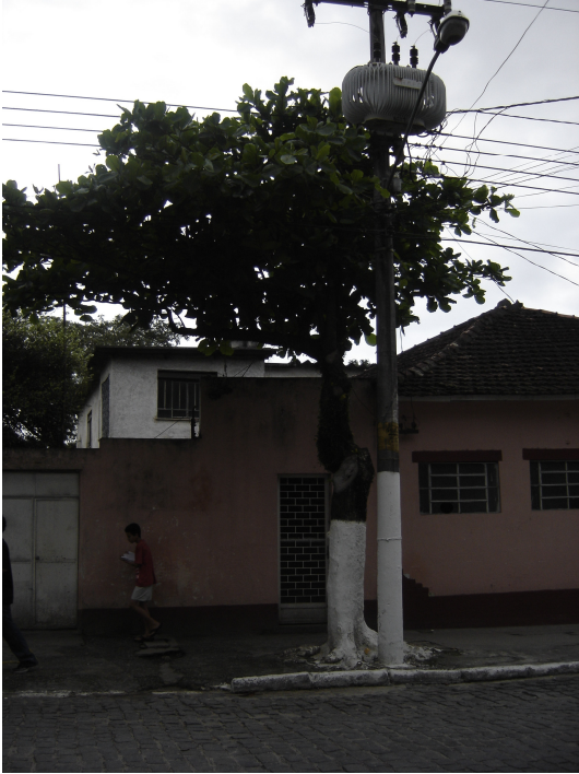
Figura 5. Conflito com a fiação, calçamento e prédio.
