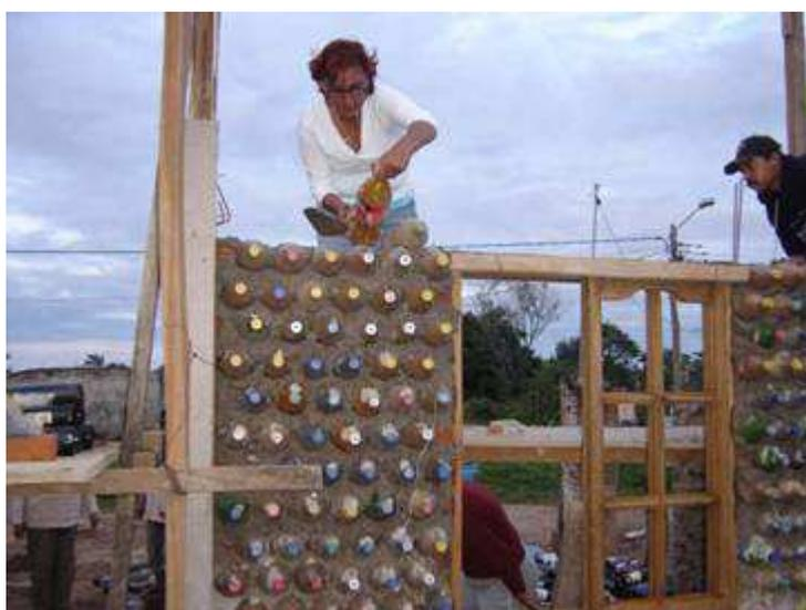
**Figura 11** – Construção de parede com garrafas PET dispostas horizontalmente em meio à argamassa
