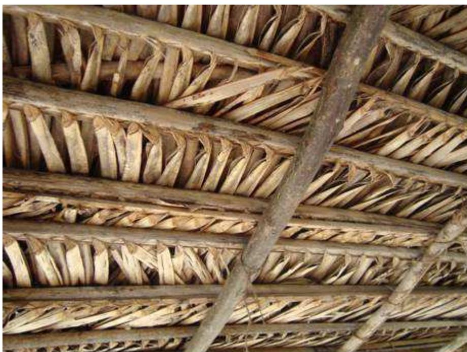
**Figura 4** – Cobertura com palha de coqueiro lisa fixada ao madeirame do telhado com cordão de sisal
