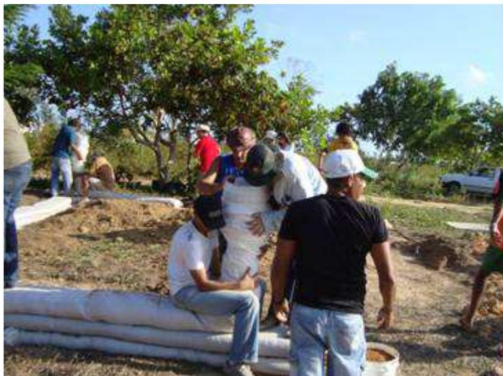
**Figura 27** – Enchimento do saco de rafia em rolo com balde sem fundo
