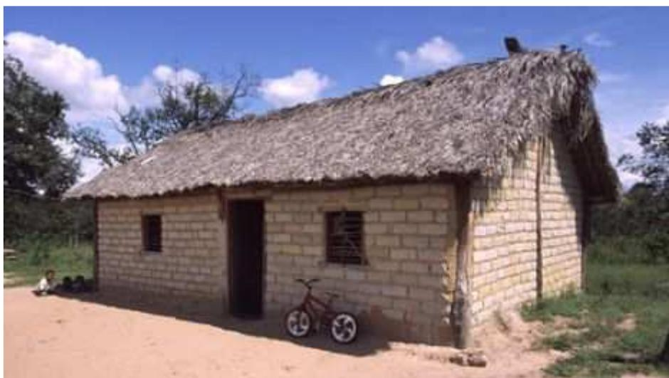
**Figura 24**– Construção com tijolos de adobe concluída
