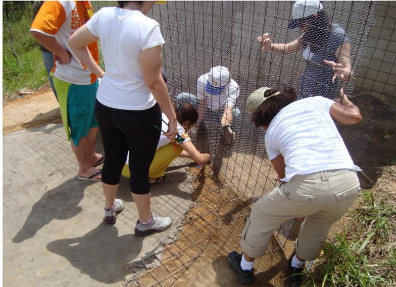
**Figura 36** – Esquema de preparação da placa de sustentação da argamassa no revestimento interno da cisterna
