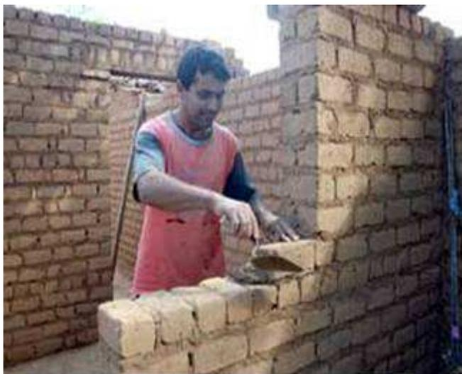
**Figura 23** – Assentamento dos tijolos de adobe com a mesma massa que os constituem
