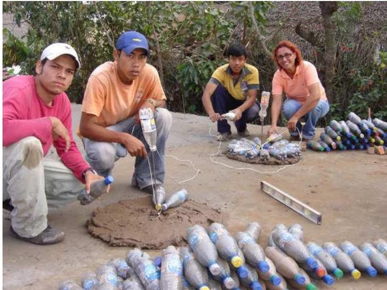
**Figura 12** – Construção de base de coluna com garrafas PET dispostas horizontalmente em meio à argamassa
