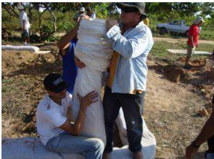
**Figura 7** – Preenchimento de saco de ráfia longo, com auxílio de balde sem fundo
