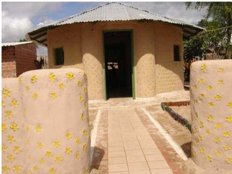
**Figura 13** – Aspecto da obra concluída com garrafas PET dispostas horizontalmente em meio à argamassa<sup>3</sup>
