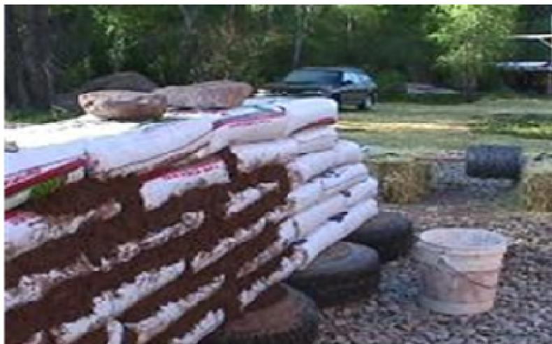
**Figura 25** – Fundação para construção com superadobe<sup>5</sup>
