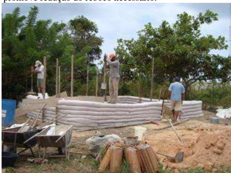
**Figura 28** – Pilamento dos sacos de rafia de superadobe<sup>6</sup>
