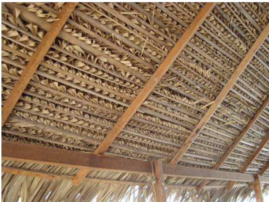
**Figura 5** – Cobertura com palha de coqueiro trançada fixada com pregos ao madeirame
