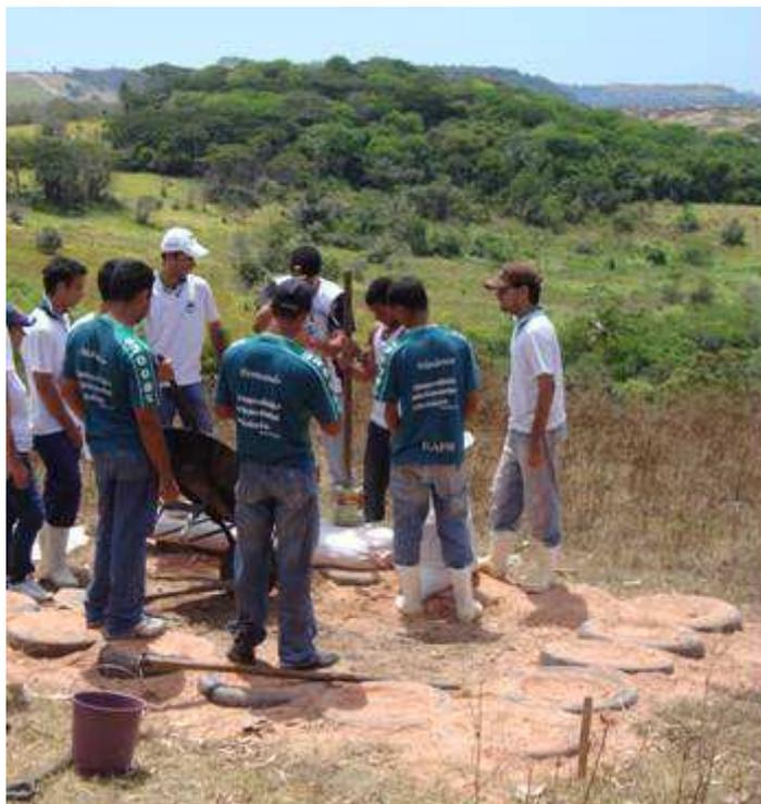
**Figura 15** – Base de aprisco em construção, feita com pneus usados<sup>4</sup>
