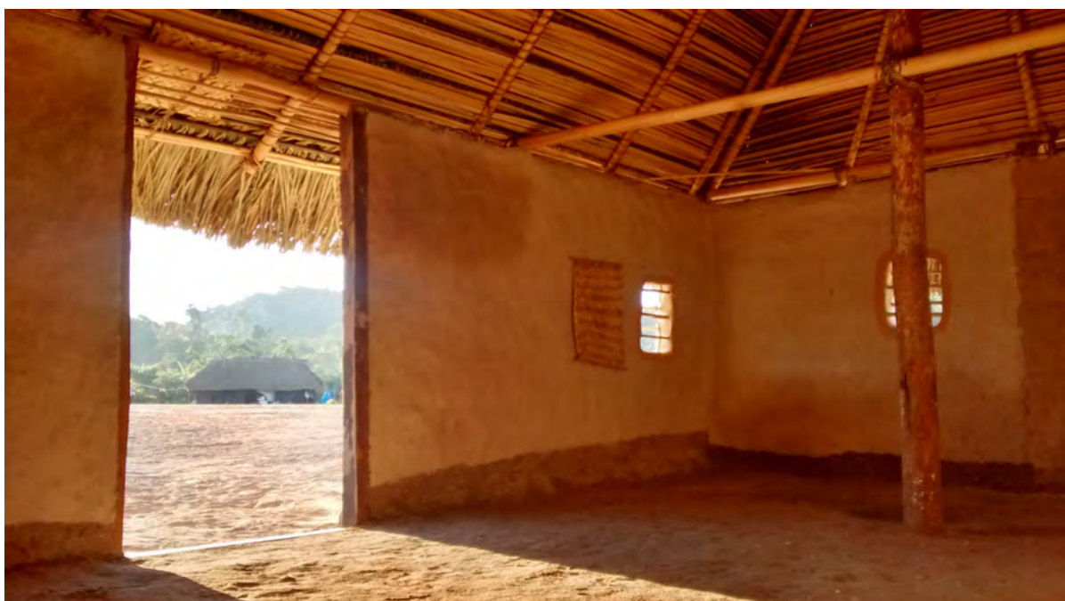
Figura 10 - Vista interna da maloca de pau-a-pique
