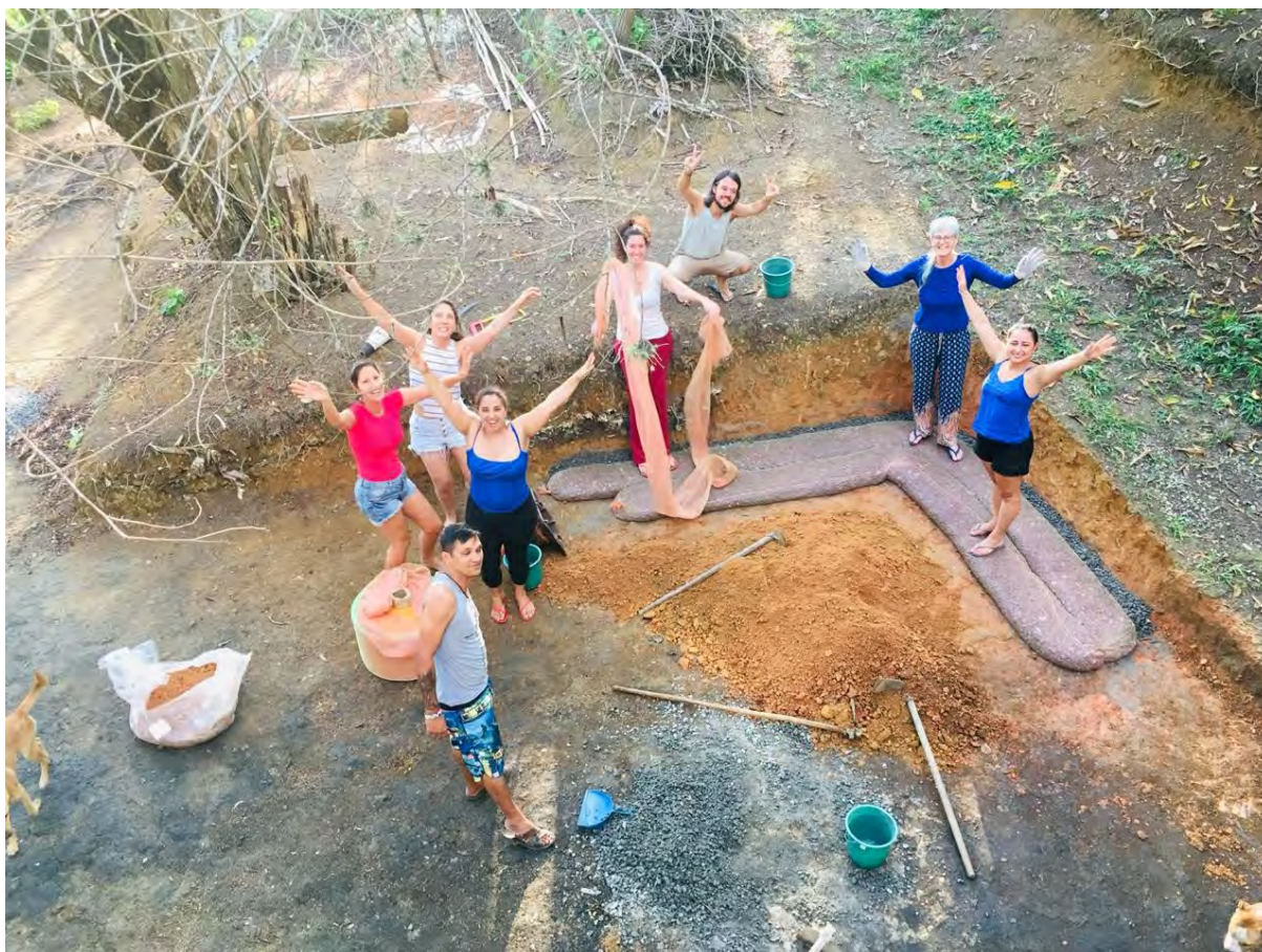
Figura 26 - Primeira fiada de brita pronta
