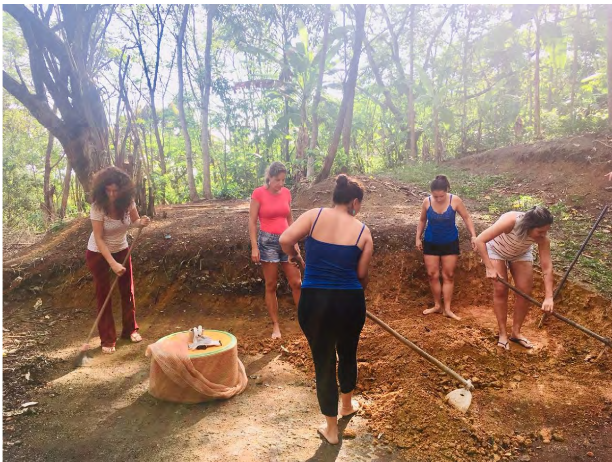
Figura 25 - Limpeza coletiva do espaço da obra
