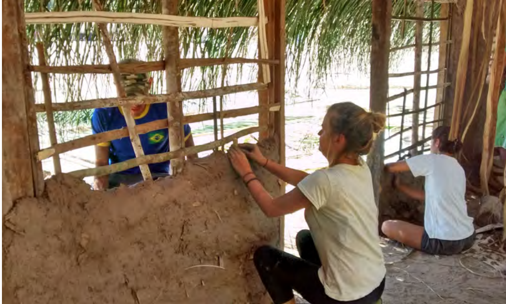
Figura 8 - Fechamento das paredes com pau-a-pique: atividade que desperta a comunhão
