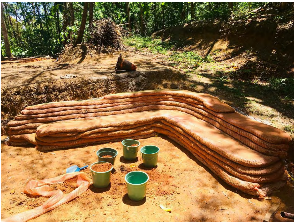
Figura 30 - Estrutura do banco finalizada
