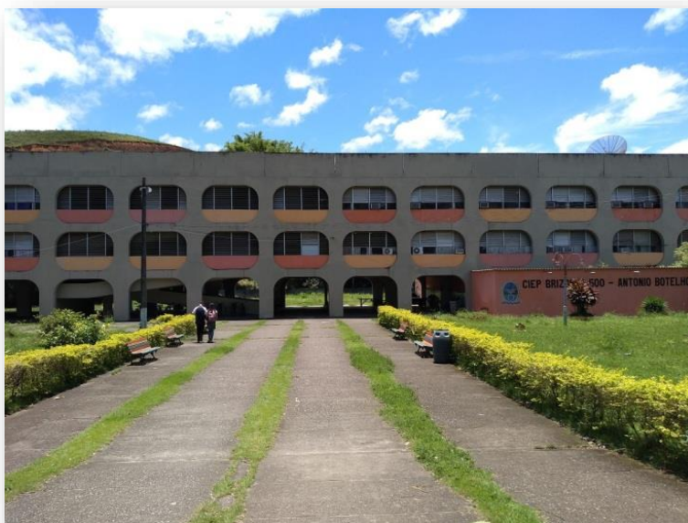
Figura 1: Fachada do CIEP 500 - Antonio Botelho - Paracambi, RJ - 2020
