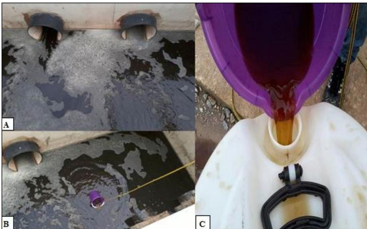
Figura 8 - Lixiviado bruto do CTR Rio. A) Tanque receptor. B) Coleta. C) Armazenamento.
