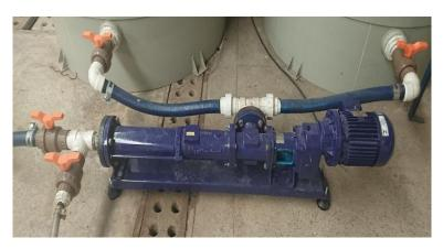
Figura 19 – Bomba posicionada na saída dos tanques de armazenamento.
