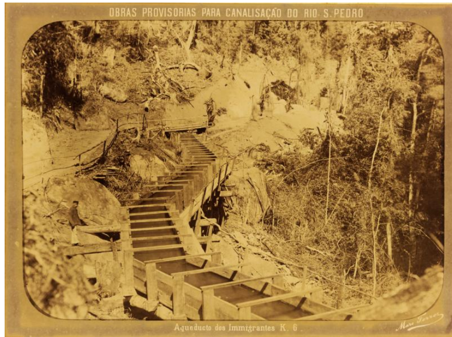
Figura 21: Construção do Aqueduto dos Imigrantes (1889)
