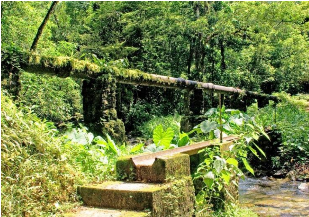
Figura 35: Tubulação de água do rio São Pedro passando por dentro da ReBio Tinguá Fonte: http://jornalfolhadoiguassu.blogspot.com.br (2015)
