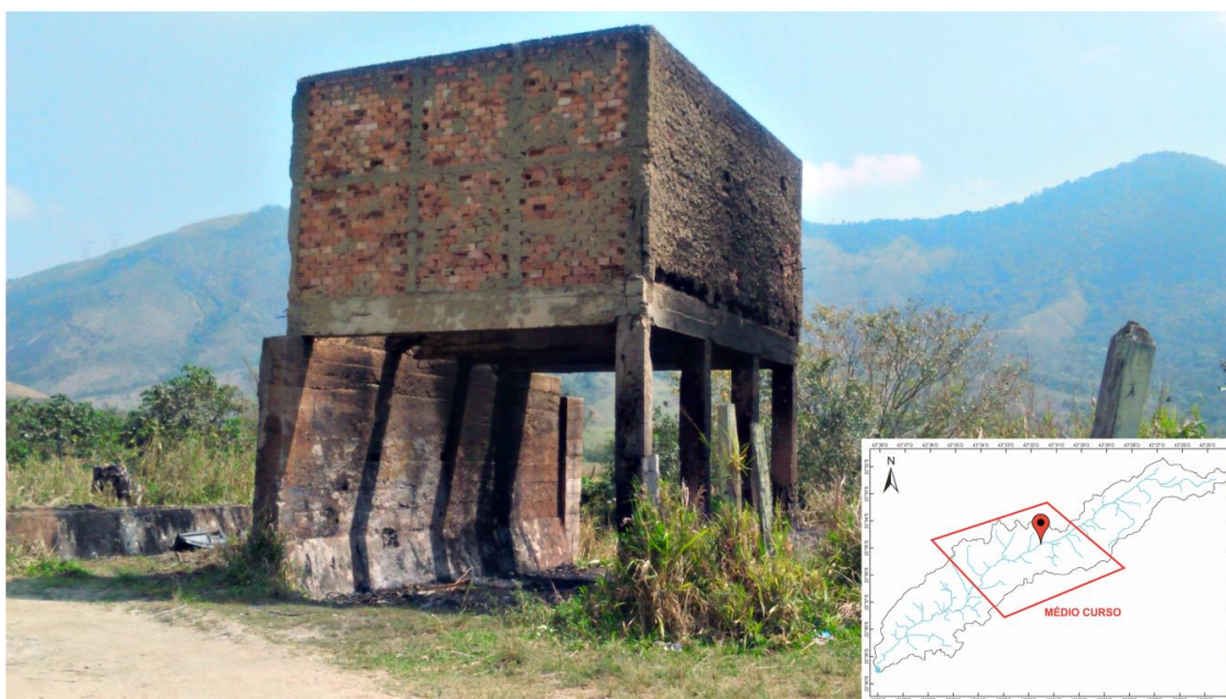
Figura 74: Cava no bairro Pedra Lisa - desativada há aproximadamente 30 anos
