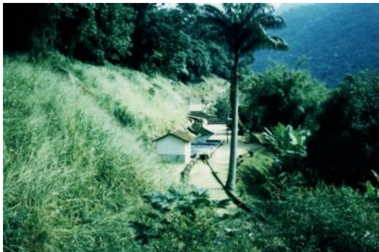
Figura 30: Vista parcial do sistema de adução da Barragem Superior
