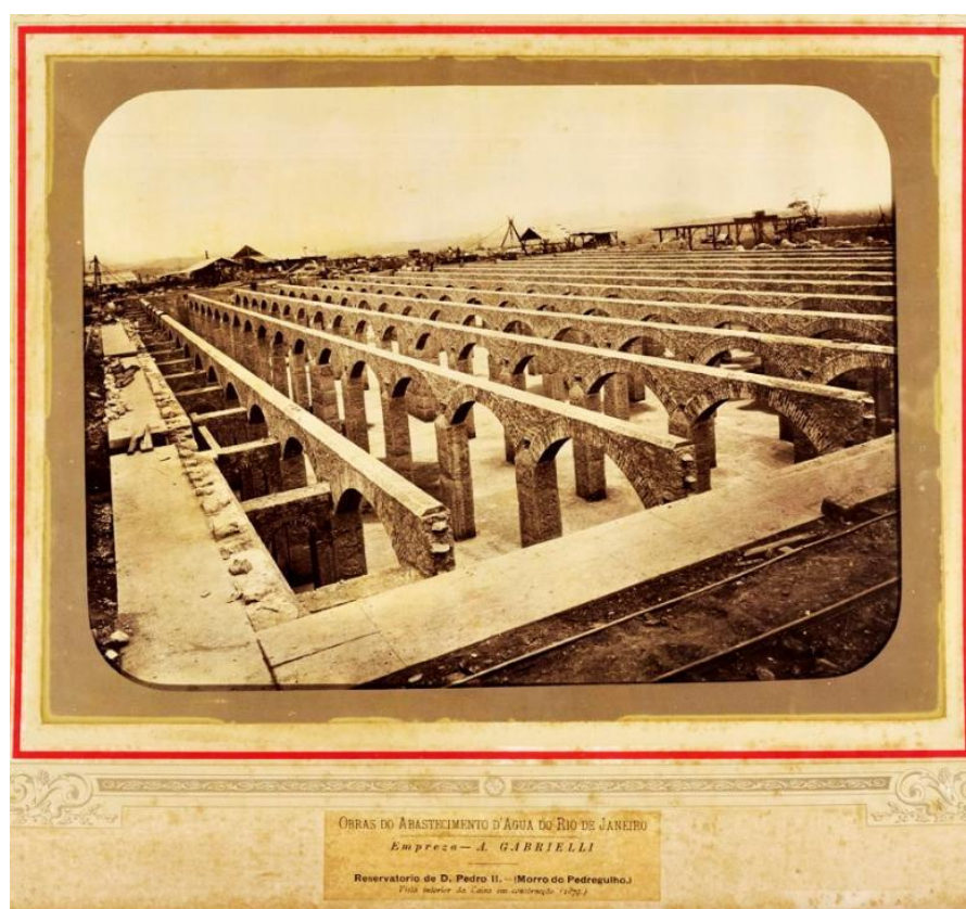
Figura 24: Interior da caixa d'água do Reservatório do Pedregulho – Quinta Imperial do Caju (1879)
