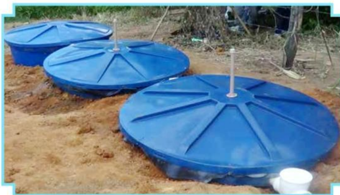
Figura 87: Fossa séptica construída
