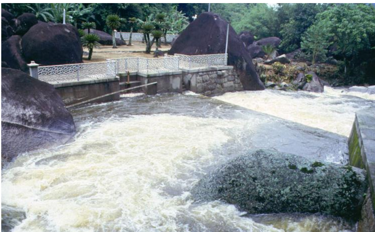
Figura 29: Unidade de Tratamento de Água São Pedro
