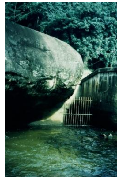
Figura 33: Tomada d'água da Barragem Superior
