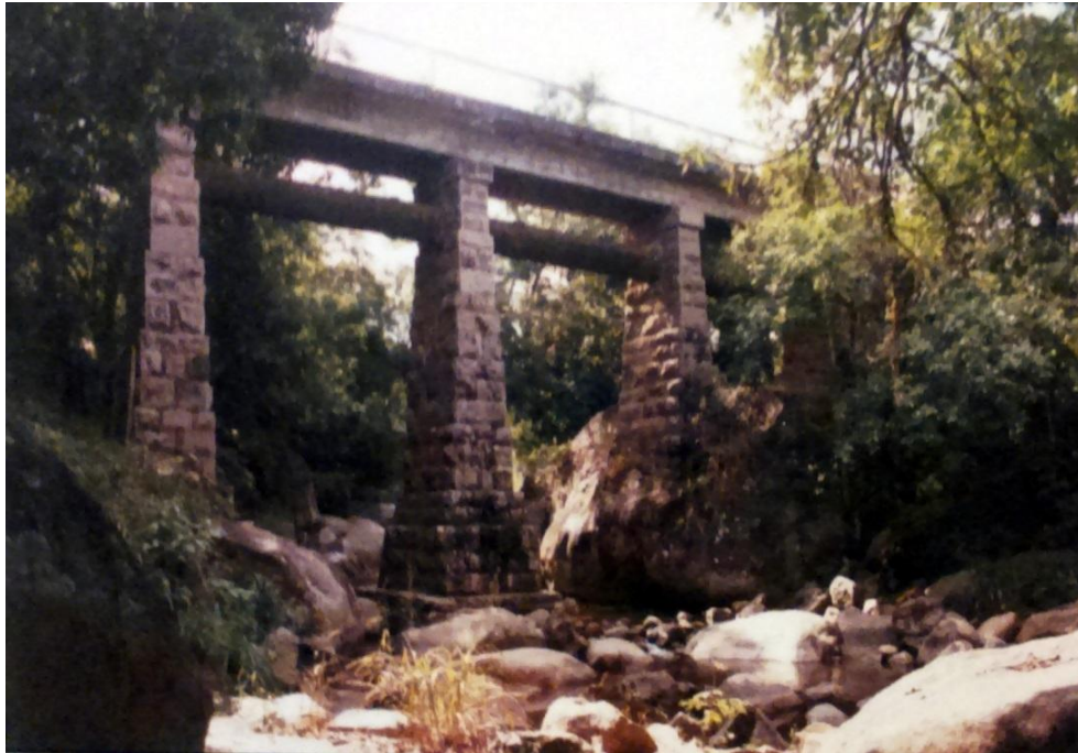
Figura 34: Tubulação do fornecimento de água do rio São Pedro – Local: Jaceruba-Nova Iguaçu/RJ Fonte: wikimapia.org/31417372/pt/Antiga-Ponte-Ferrovia-para-a-Represa (1995)
