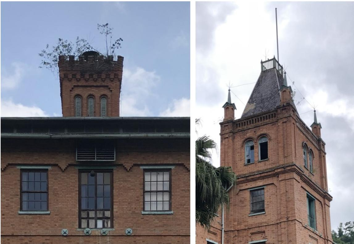
Figura 47 Detalhes da fachada principal, arbustos no telhado e janelas quebradas. Fonte: Autor, 2020.
