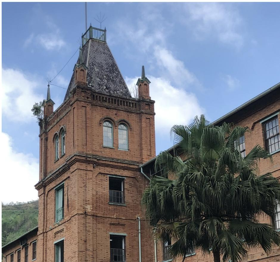
Figura 48 Torre da escadaria com vegetação no telhado e faltando telhas. Fonte: Autor, 2020.
