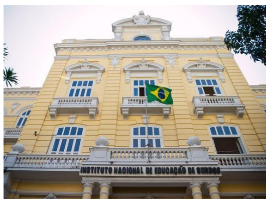
Figura 1.4: Fachada do INES, localizado no bairro das Laranjeiras, no Rio de Janeiro (O DIA, 2013).
