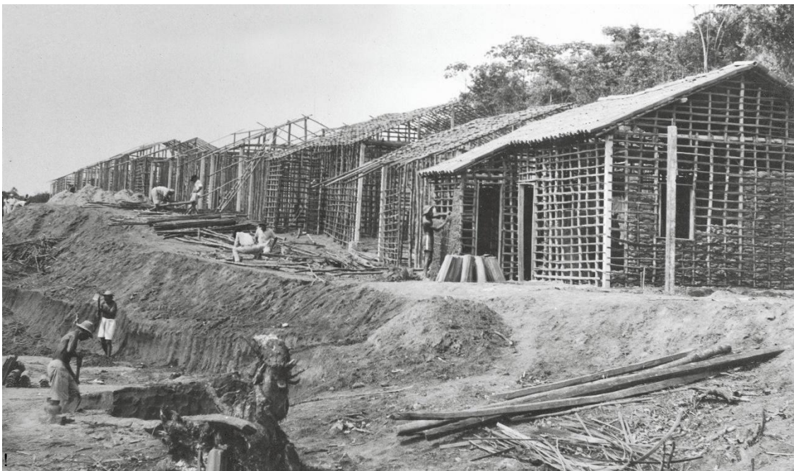
Construção de casas populares. Recife, década de 1950.
