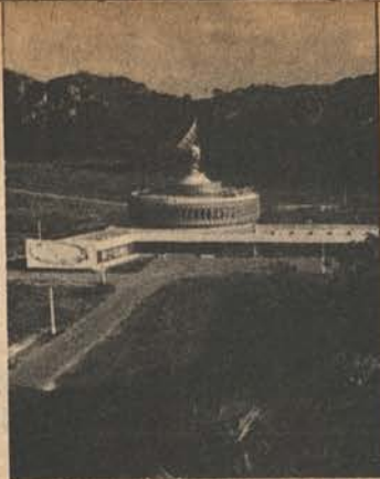
Una de las estaciones de transmisión vía satélite que garantizarán las comunicaciones internacionales
