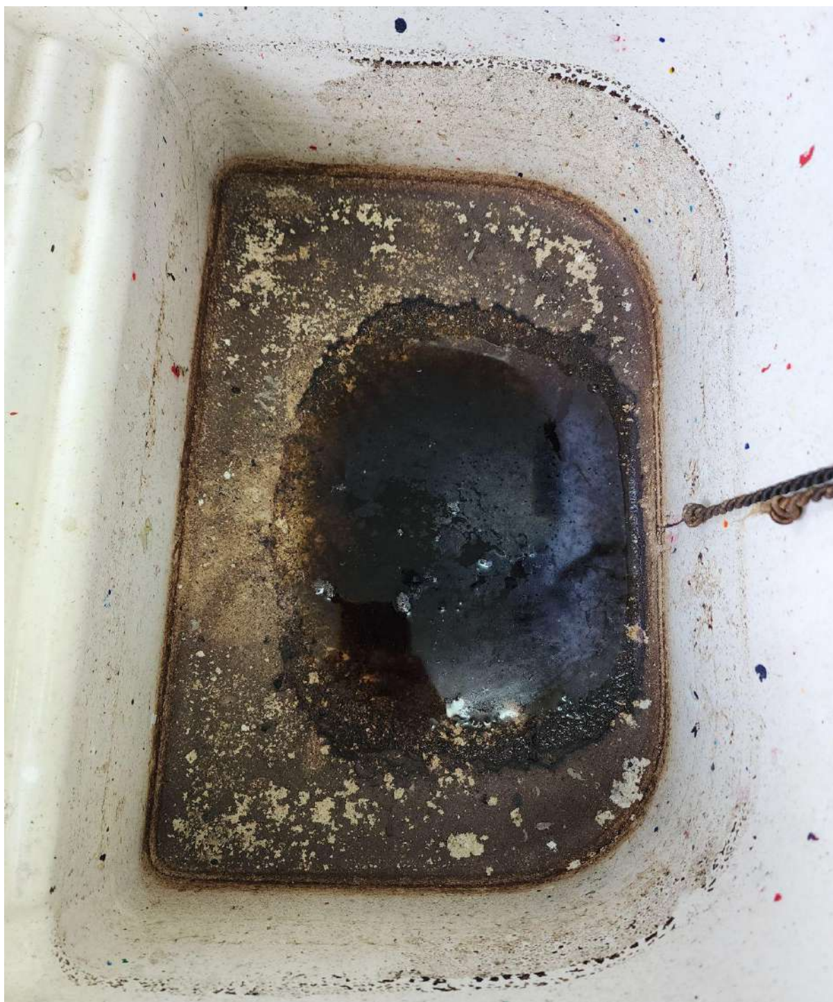
Figura 31: Pia entupida com produtos químicos não identificados, com possível indicação de descarte irregular. Fonte: Acervo do autor (2025).
