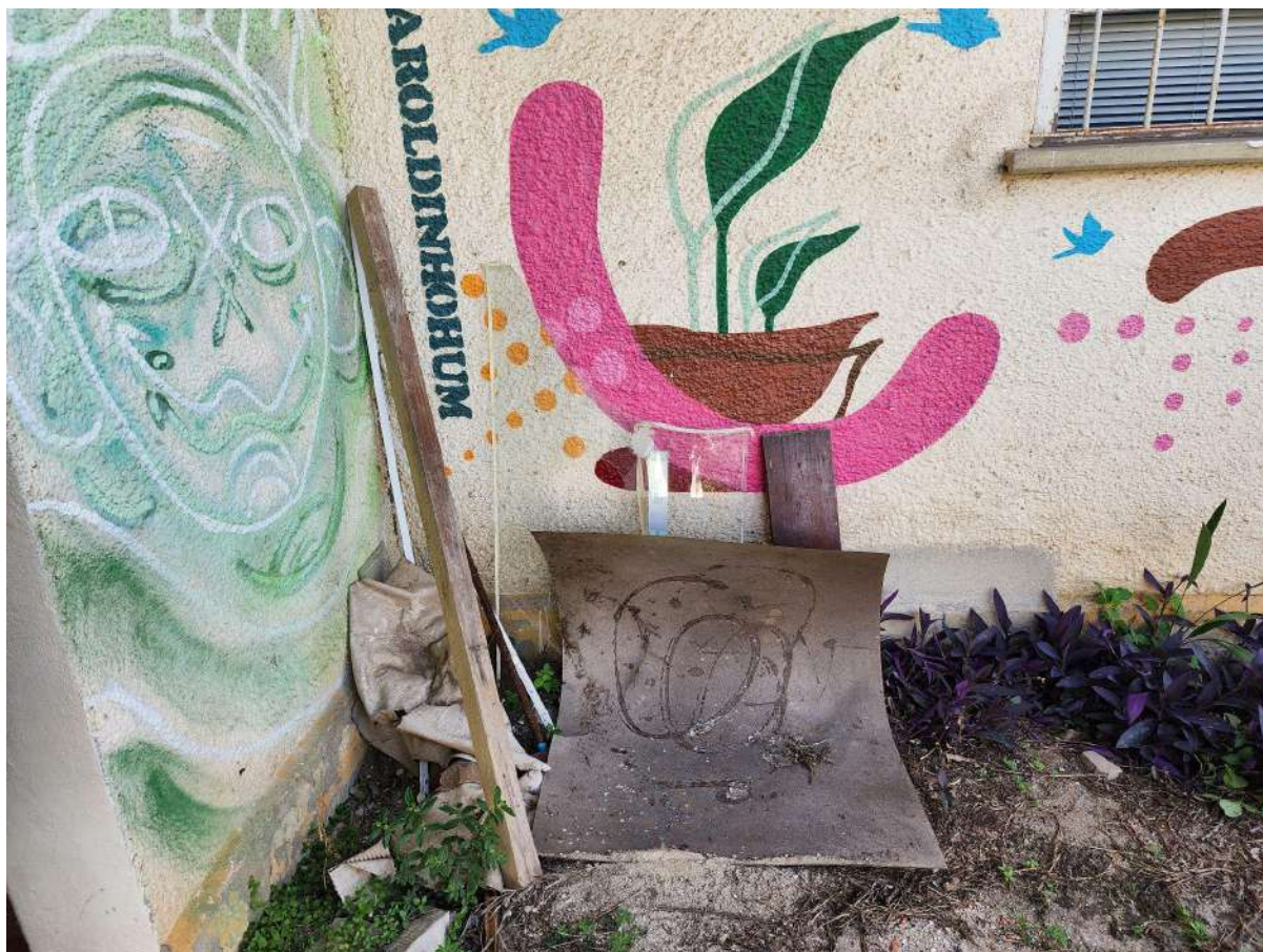
Figura 27: Canteiro próximo ao corredor de acesso entre ICHS e IE, com resíduos de materiais de construção, tal como madeira e vidro. Fonte: Acervo do autor (2025).
