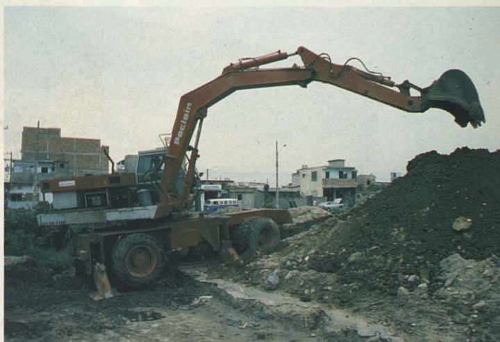
Obras de saneamiento básico - (Brasil)
