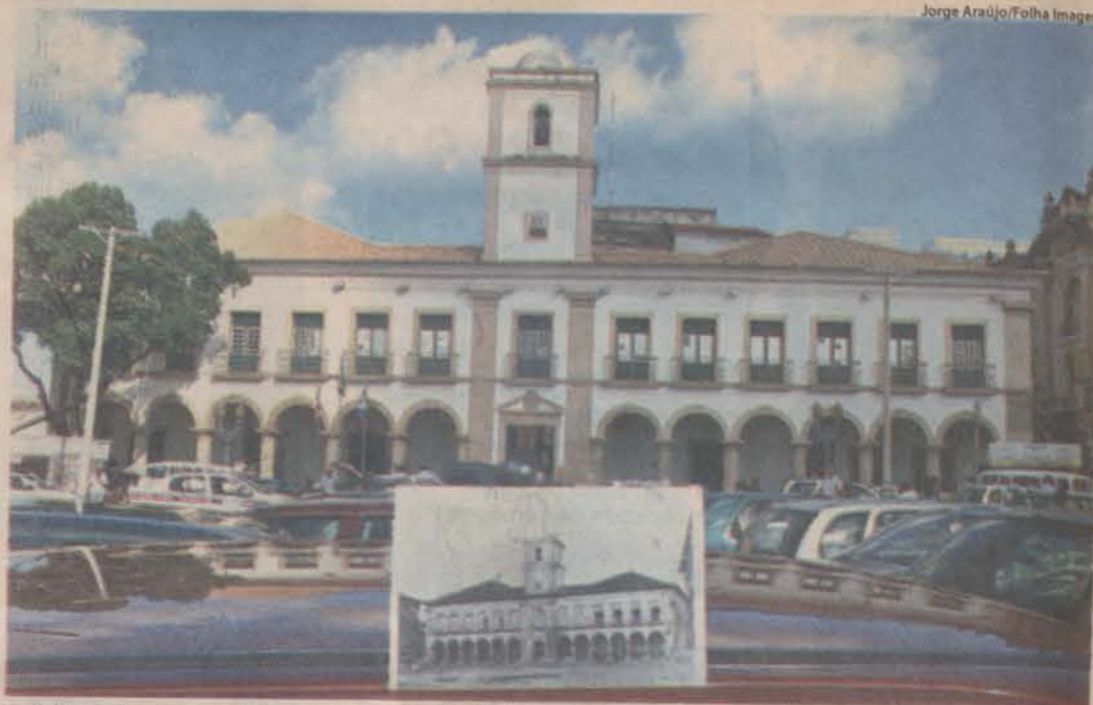
Prédio da Câmara Municipal, de 1549, em Salvador; à frente, gravura do edifício de 1860
