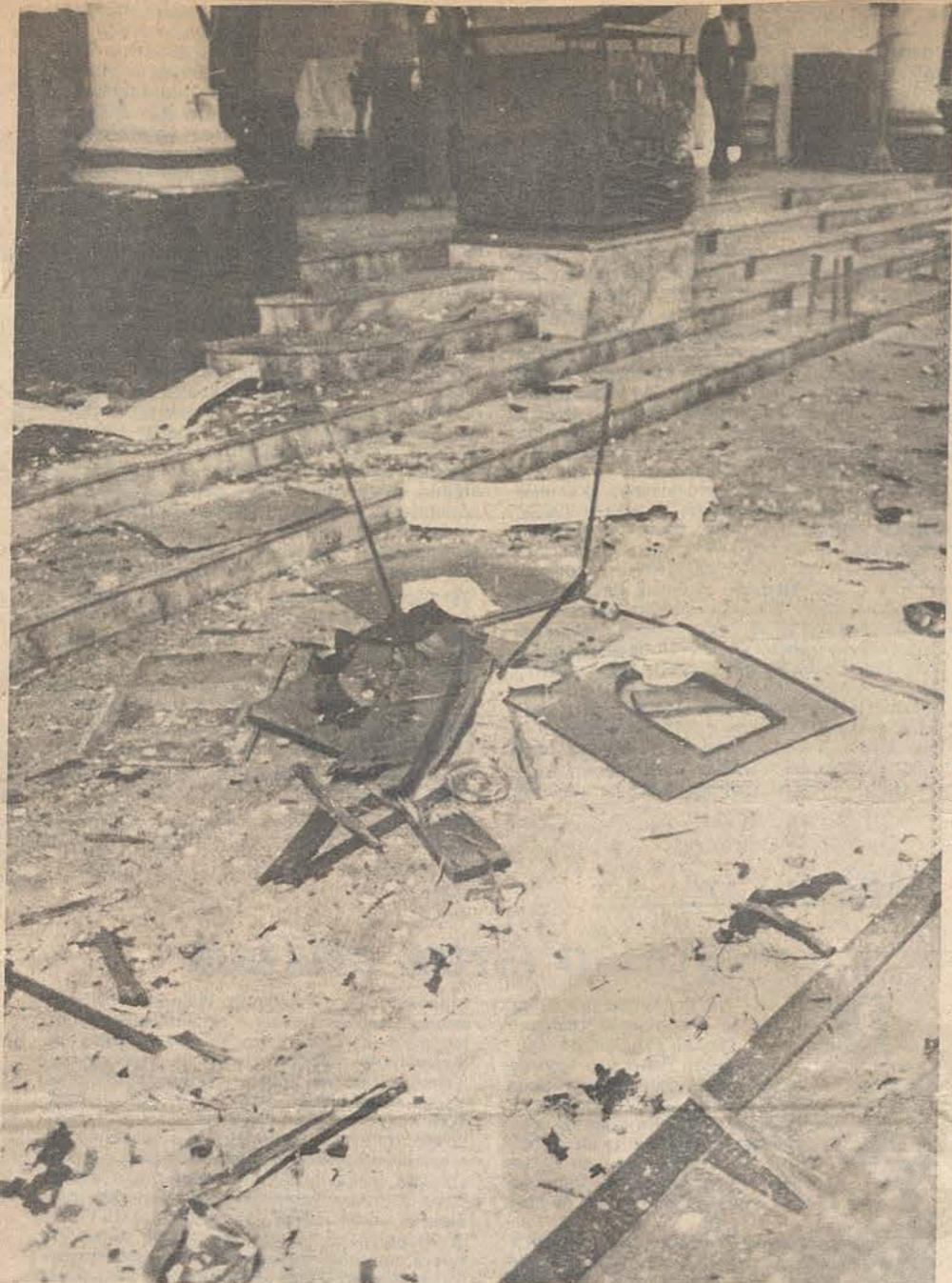
A explosão foi ouvida a um quilômetro de distância e destruiu parte do altar
