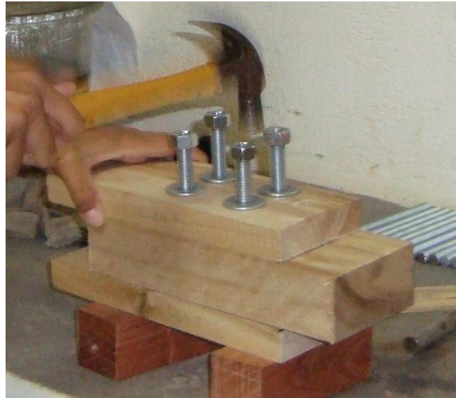
Figura 8. Montagem do corpo-de-prova de barra rosqueada C. citriodora .
