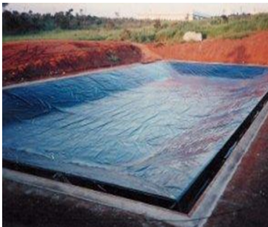
Figura 5. Ilustração da aplicação de manta de polietileno de alta densidade (PEAD) em uma bacia de contenção.
