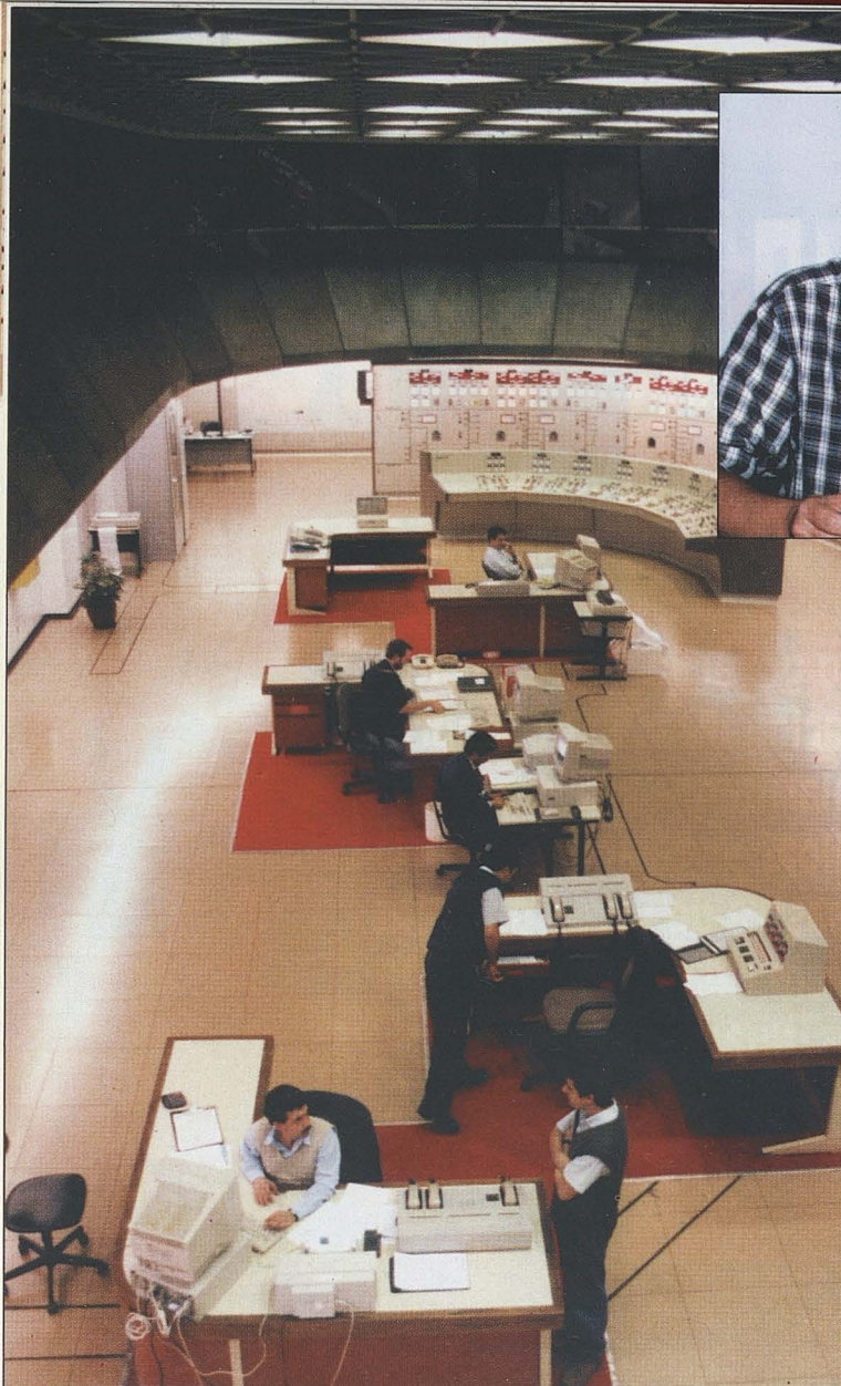
Centro de Controle da Usina de Itaipu, numa das abastecedoras do Rio de Janeiro
