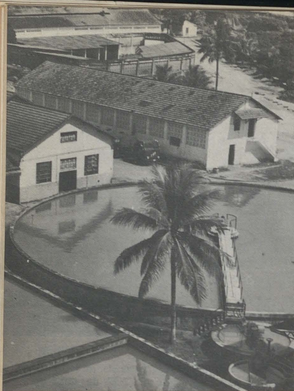
Reservatório de água para a mistura com caldo de cana
