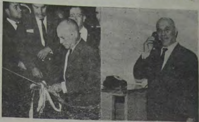
Dois flagrantes das inaugurações. Na foto à esquerda, o gov. Paulo Torres desata a fita simbólica da Central Telefônica desta cidade; na segunda, o momento em que s. exa. utilizava um dos novos aparelhos comunicando-se com o Palácio do Ingá.
