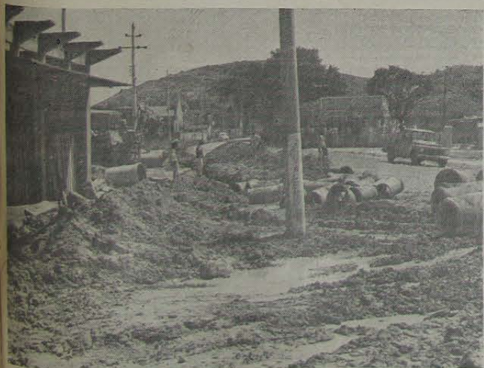
Obras em execução na rua Geni Saraiva (Ponto Chic).
