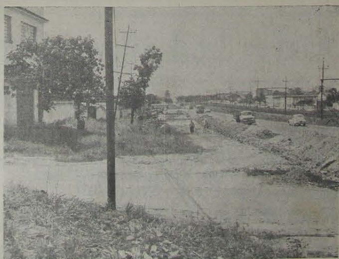
Aspecto dos trabalhos de duplicação da Av. Getúlio Moura.
