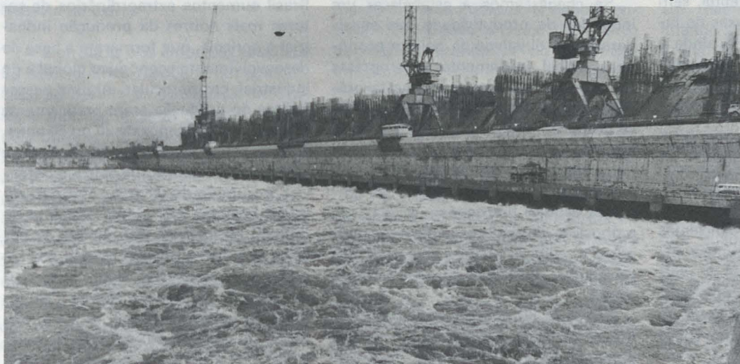
O potencial hidrelétrico do país torna-se realidade através da ação coordenada pela Eletrobrás
