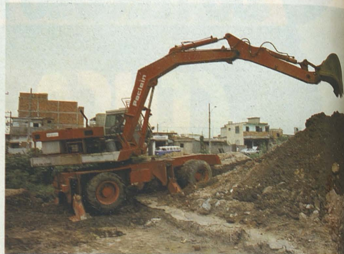
Obras de saneamento básico — Brasil
