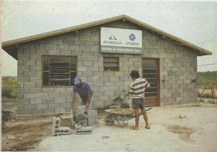
Construção de habitações pelo sistema TRAMA BLOCOS — Brasil
