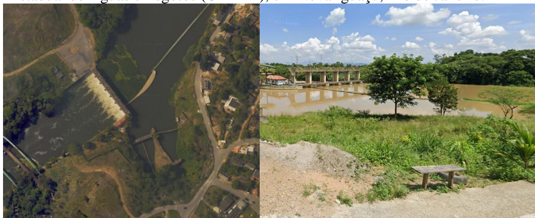
Figura 5. Estação GN200 localizada próxima da Barragem principal da Companhia Estadual de Águas e Esgotos (CEDAE), em Nova Iguaçu, Rio de Janeiro.
