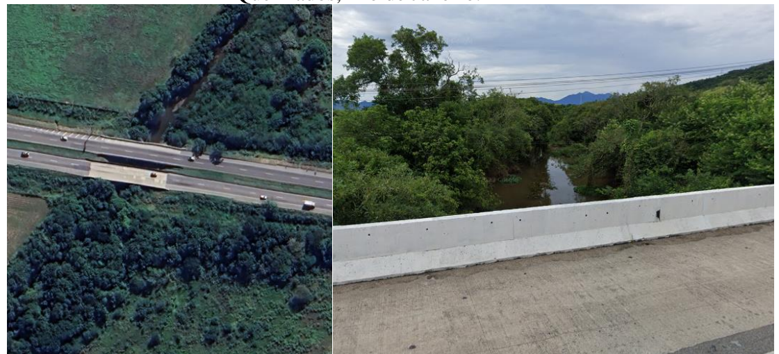
Figura 12. Estação PO290 localizada próximo da Rodovia Presidente Dutra em Queimados, Rio de Janeiro.
