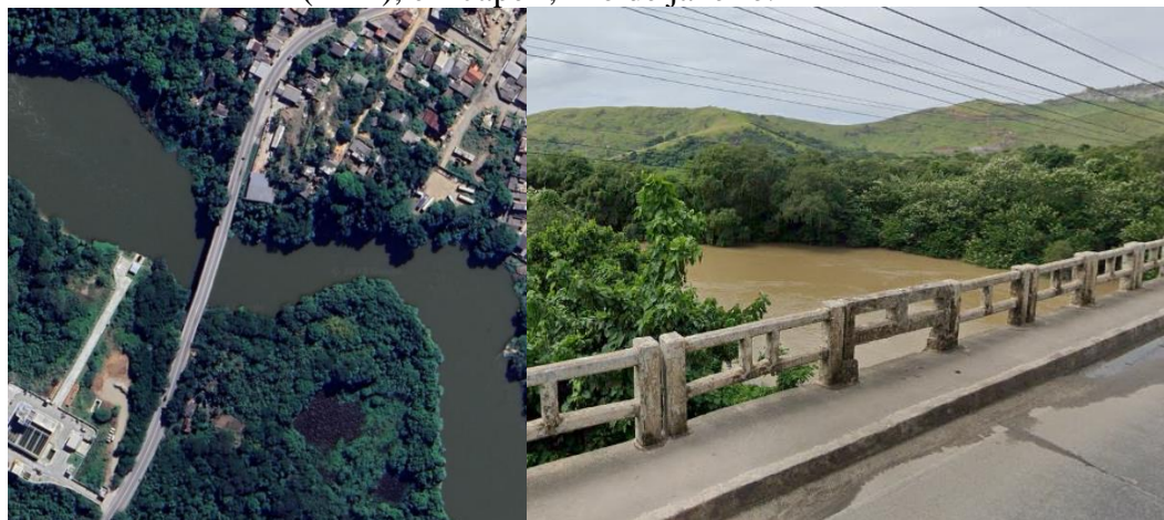
Figura 6. Estação GN201 localizada próxima da Estação de Tratamento de Água (ETA), em Japeri, Rio de Janeiro.
