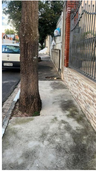
Figura 13. Exemplo de calçada. Quadra “Q-34” com 1,45 m de largura. No detalhe a árvore desta calçada possui o espaço árvore de 0,55 m de largura por 0,80 m de comprimento. Para o pedestre há 0,90 m de passagem.
