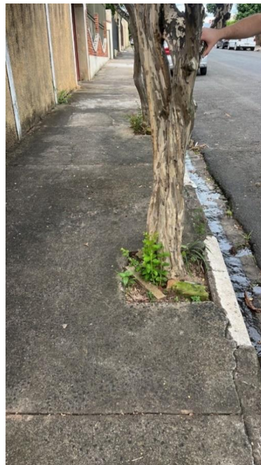
Figura 14. Detalhe da calçada da quadra “Q-5” com 1,9 m de largura. O espaço árvore nesta calçada foi teve medição de 0,50 m por 0,50 m.
