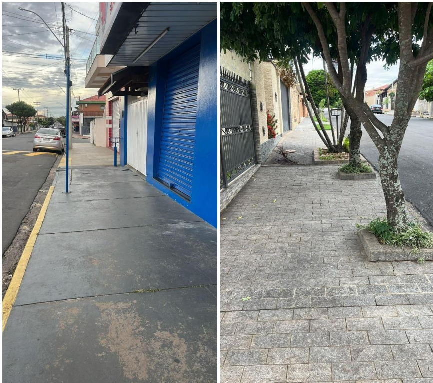
Figura 16. À esquerda, calçada Q-34 com 2,45 m de largura sem qualquer espaço árvore; à direita, calçada Q-45 com 2,55 m de largura. Em Q-45, observa-se que há o espaço árvore, porém com medidas sem padronização e que atendem ao limite de diâmetro do colo do indivíduo plantado.
