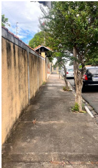
Figura 14. Detalhe da calçada da quadra “Q-5” com 1,9 m de largura. O espaço árvore nesta calçada foi teve medição de 0,50 m por 0,50 m.
