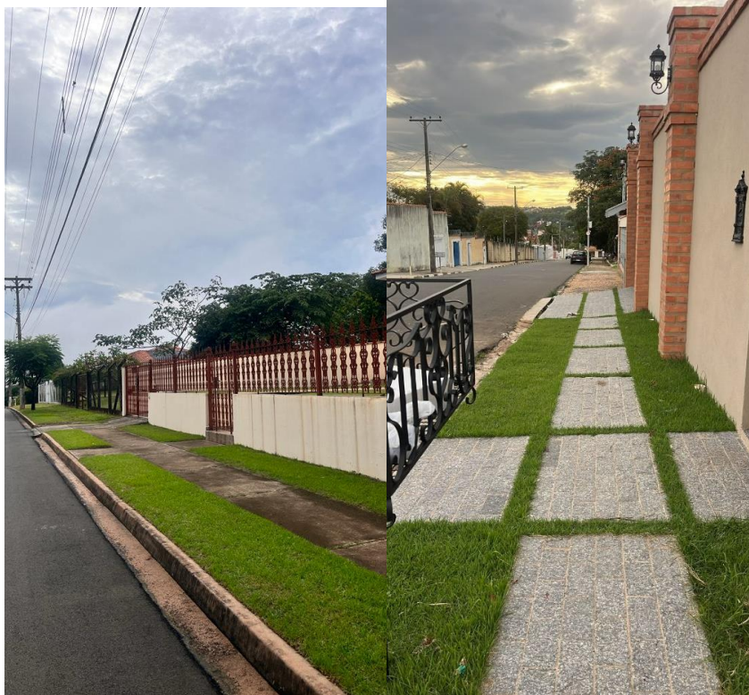
Figura 15. Exemplo de calçadas com área de infiltração e área de passagem de pedestre. Nestes casos ambas as caçadas possuem 2,3 m de largura.
