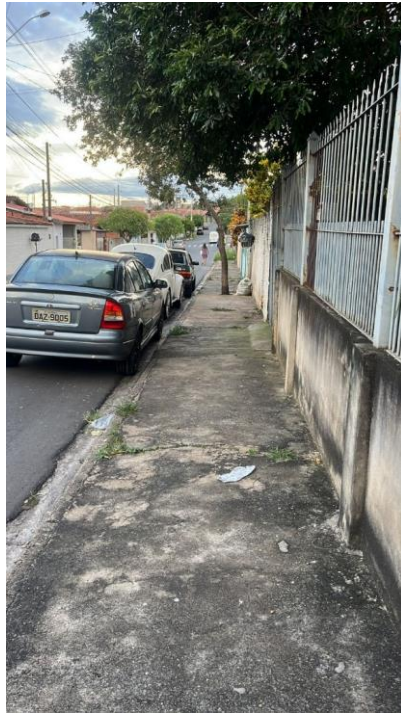
Figura 13. Exemplo de calçada. Quadra “Q-34” com 1,45 m de largura. No detalhe a árvore desta calçada possui o espaço árvore de 0,55 m de largura por 0,80 m de comprimento. Para o pedestre há 0,90 m de passagem.
