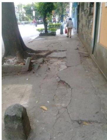
**Figura 11** Afloramento do sistema radicular com possibilidade de construção de rampas.
