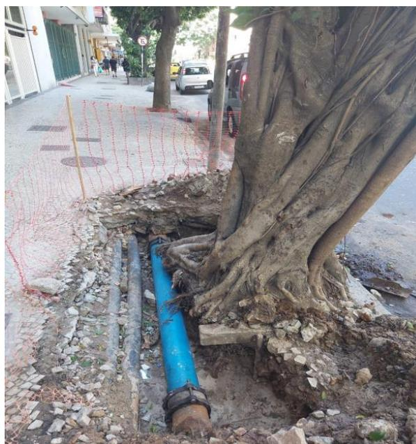
**Figura 9** Conflito entre sistema radicular e a tubulação
