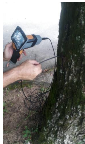
Figura 20. Uso do boroscópio para verificação da condição interna do fuste.
