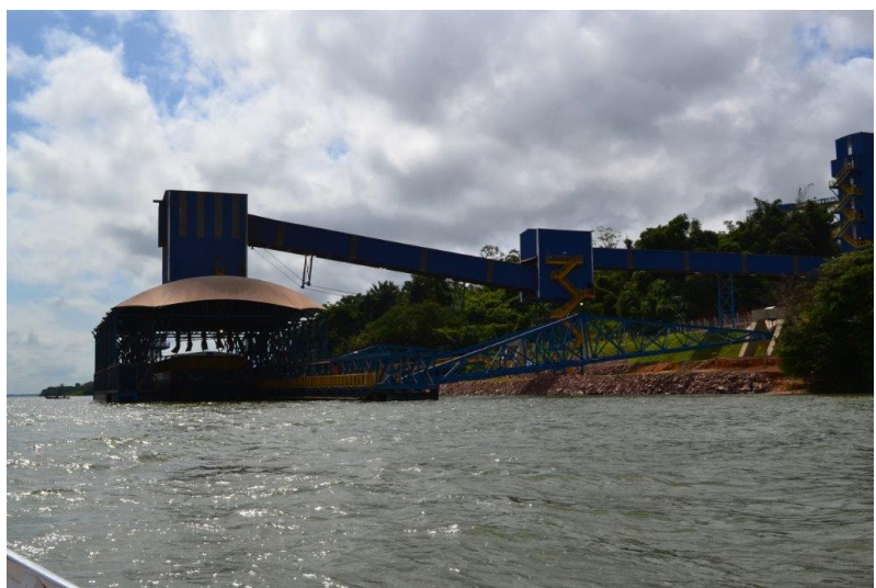
Foto D24 – A estrutura recebe as barcaças para o carregamento.
