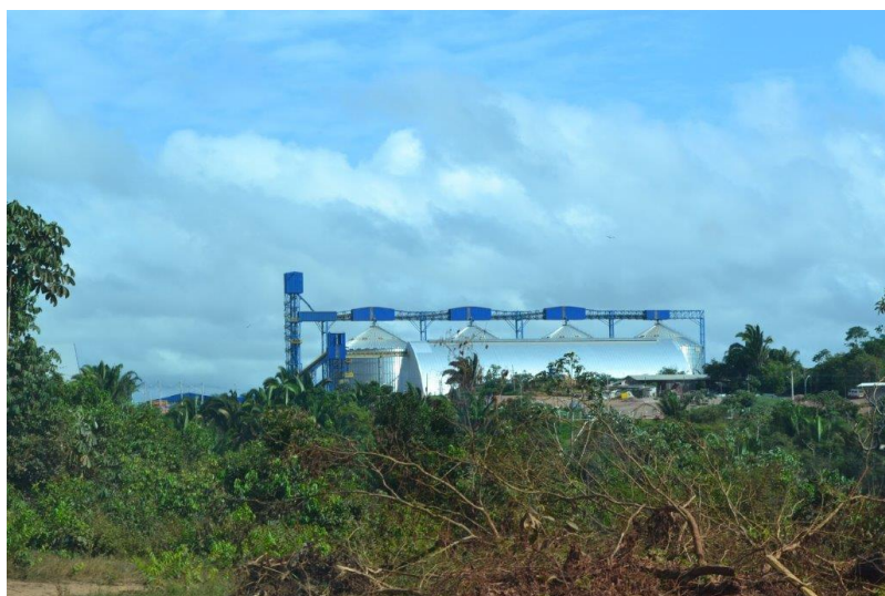
Foto D23 – A estrutura da Bunge em Miritituba, município de Itaituba – PA é imponente, mesmo vista da estrada.
