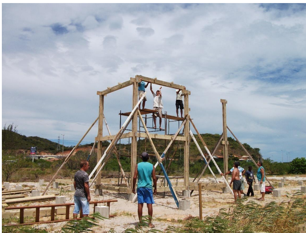
Construção do Prédio do IPUFRJ. Acervo: LABIME/IPUFRJ)
