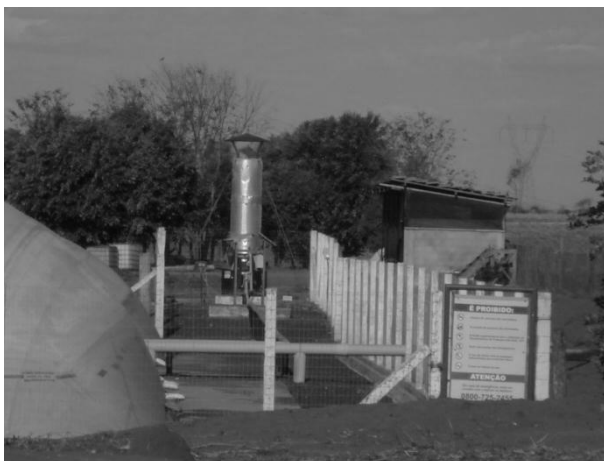
Figura 1 – Granja de suínos pesquisada com 2 biodigestores e queimador de biogás.
