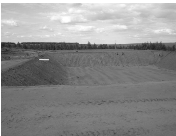
Figura 3 – Lagoa de estabilização do tipo anaeróbia com fundo trapezoidal sem revestimento em fase de construção.
