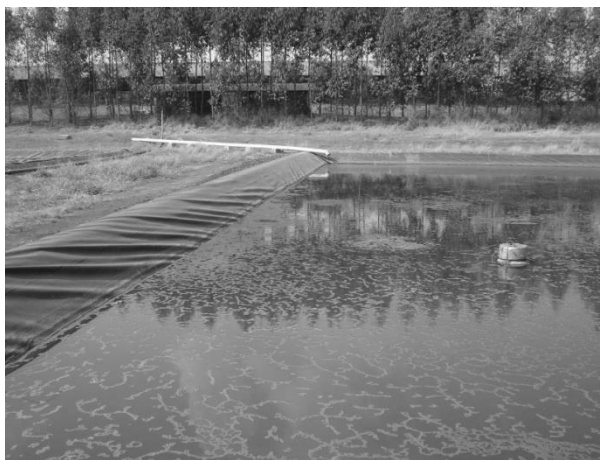
Figura 19 – Lagoa de estabilização de DLS com a câmara posicionada para amostragem.
