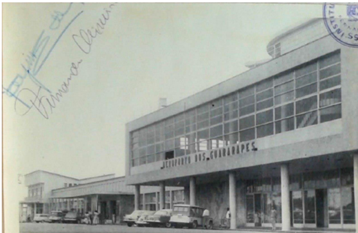
Figura 6 – Fachada do Aeroporto dos Guararapes, em 25 de julho de 1966
