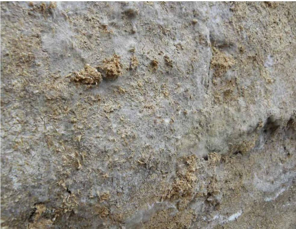
Figura 6- Bolor na parede do tanque de armazenamento da cevada da *Propriedade D*.
