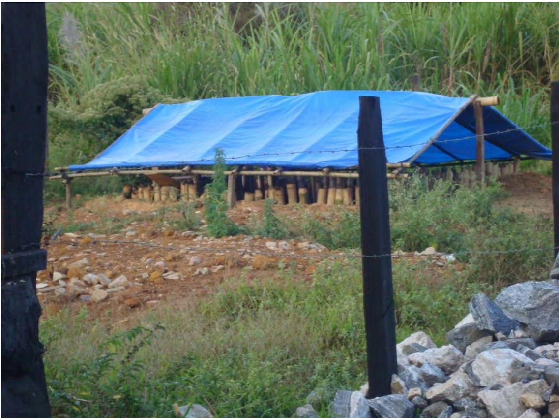
Figura 1- Local de armazenamento da cevada na *Propriedade A* com paredes revestidas de bambu e cobertura de lona.
