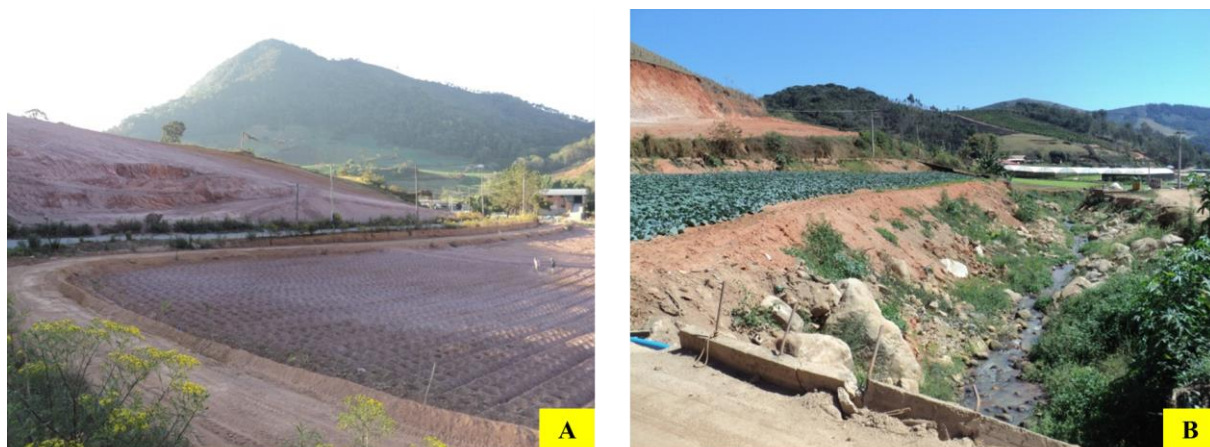
Figura 2. A) substituição do solo por subsolo em Nova Friburgo. B) Corte de “barranco” para substituição de solo em Teresópolis. Fonte: Felipe (2011).
