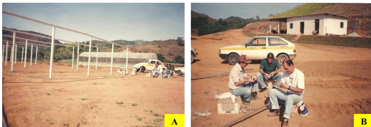
Figura 14. Início da construção da estrutura para o viveiro de mudas arbóreas. B) – Técnicos da Emater-Rio (Paulo Mundim e Eiser) e diretor de agricultura do município (Alcenir), montando a irrigação. Fonte: Felipe (1997).
