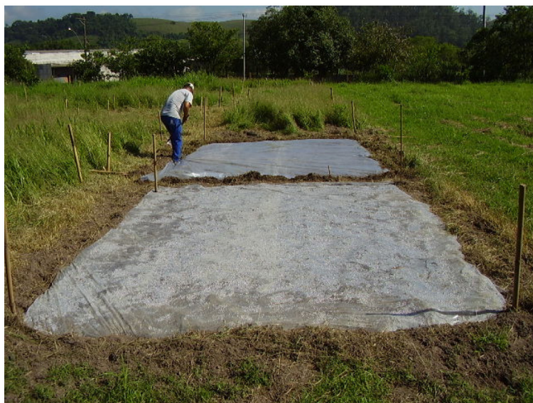
Figura 2. Colocação da cobertura plástica para solarização das parcelas. Módulo Agroecológico, IFRJ – Campus Nilo Peçanha, Pinheiral/RJ, janeiro/2012.
