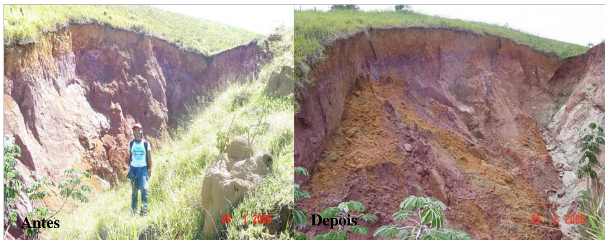
Figura 21: Desmoronamento de talude da voçoroca em recuperação. À esquerda, foto em 24/01/06 e à direita em 25/02/06.
