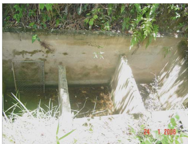
Figura 20: Vista do coletor de sedimentos vazio na voçoroca recuperada, contendo serapilheira e água, em 24 de janeiro de 2006, próximo à terceira avaliação.
