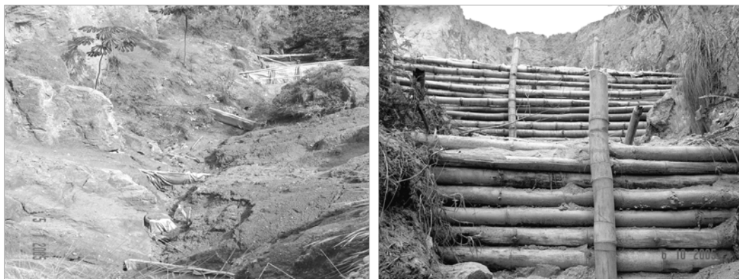
Figura 6: Paliçadas de bambu implantadas na área interna da voçoroca.
