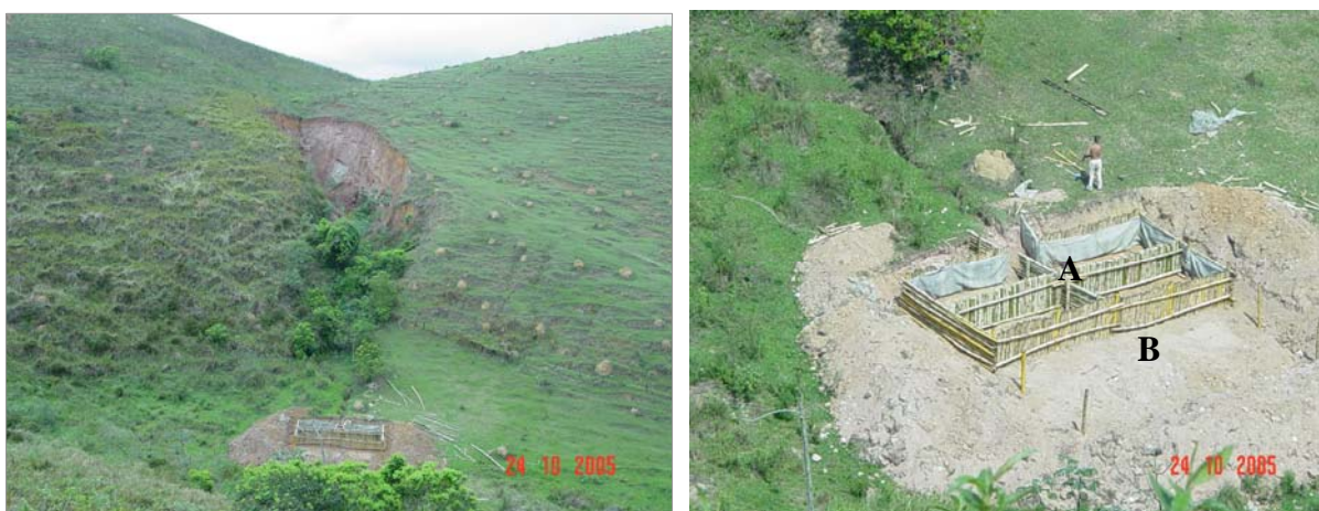
Figura 16: Vista da voçoroca sem intervenção e praça de sedimentação para coleta de sedimentos. A – Área delimitada com bambu; B – Área não delimitada.
