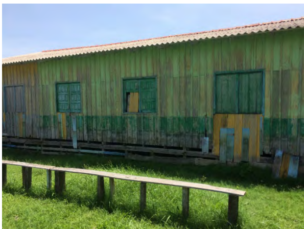
Figura 46 e 47. Madeira da parede e escada em estado crítico, em estado de apodrecimento.
