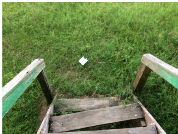
Figura 46 e 47. Madeira da parede e escada em estado crítico, em estado de apodrecimento.
