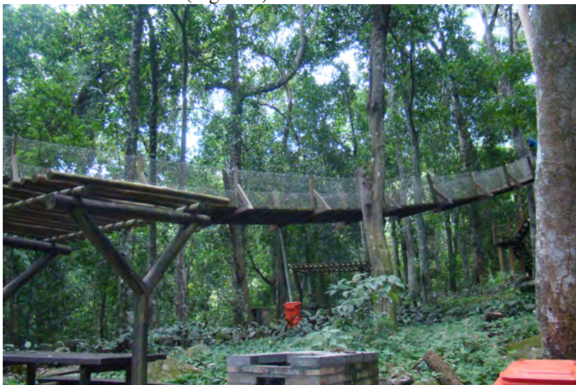
Figura 3: Aspecto da mata e da ponte na sede. (Foto: Luis F. Menezes Jr.)
