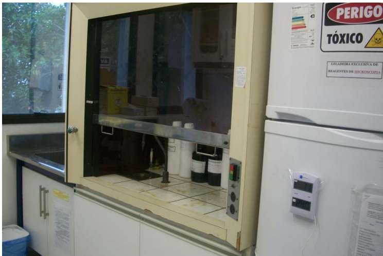
Fig. 6 Capela de exaustão
