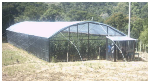
Fotografia 21– Casa de vegetação
