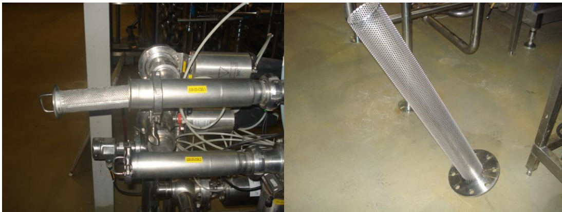
Figuras 21 e 22. Etapa de filtração
